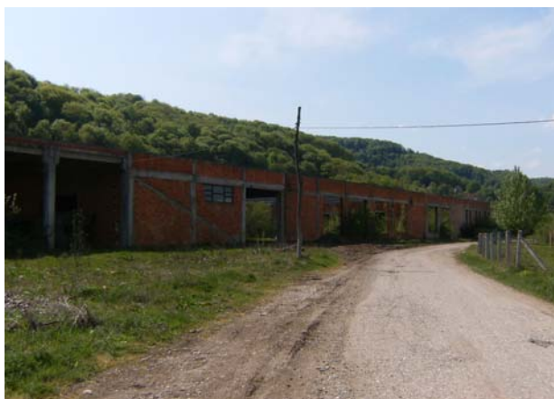
сл.1. Спољашњи изглед недовршене пиваре
