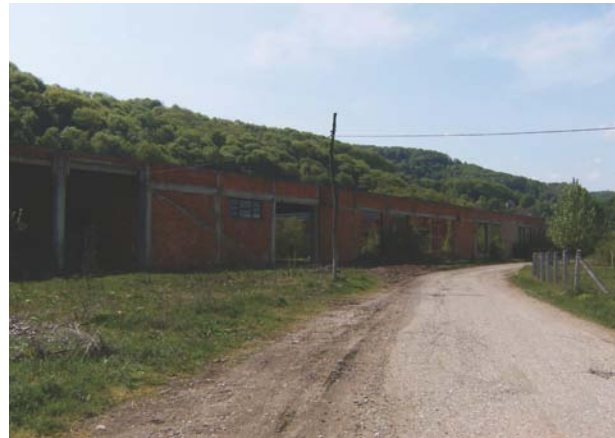
сл. 1. Спољашњи изглед недовршене пиваре
